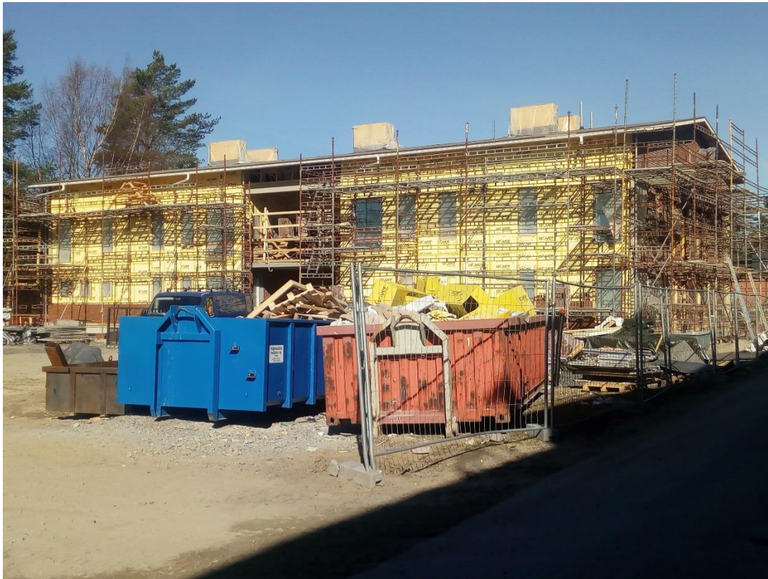
ASPA rakentaa uutta kehitysvammaisten asumisyksikköä Sepänkadulle.
