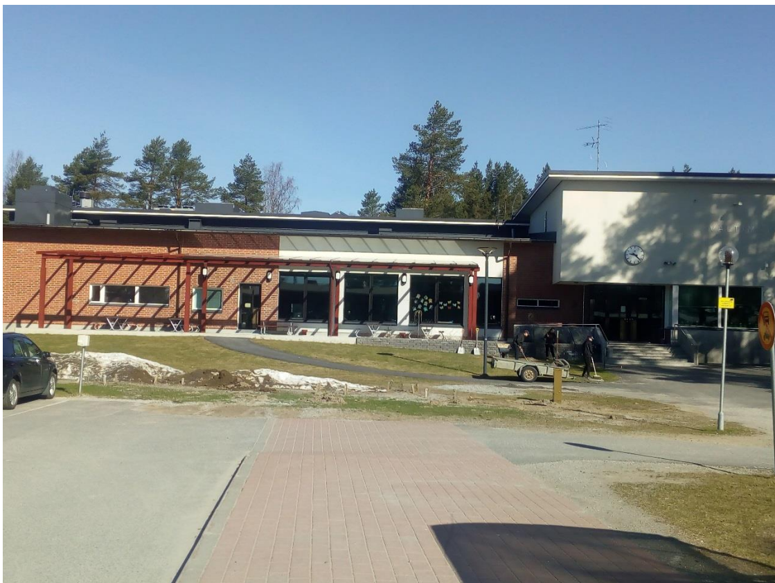
Valtimon koulun uudisrakennus otettiin käyttöön lukuvuodelle 2016-2017.
