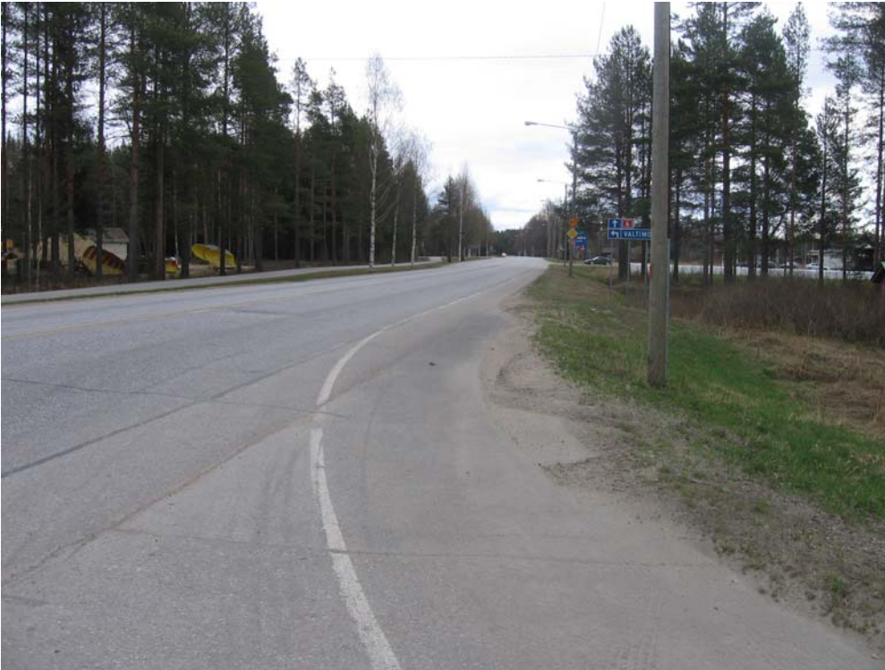
Kuva 33. Valtatiellä 6 Pajukosken liittymässä näkemät ovat hyvät, mutta liittymästä puuttuu väistötila. Läheisen huoltoaseman liittymässä on jo nykyisin väistötila.
